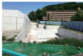
既設施設のみでの対策が難しい場合、調整池を設置して浸水を防除する。
