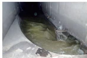
ボックスカルバート内に分水堰を設置して河川への放流を抑制する。
