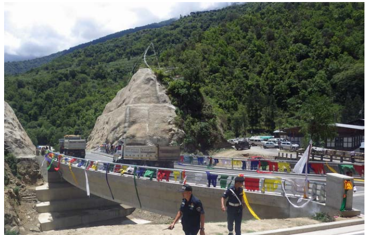
開通したチュゾムサ橋
