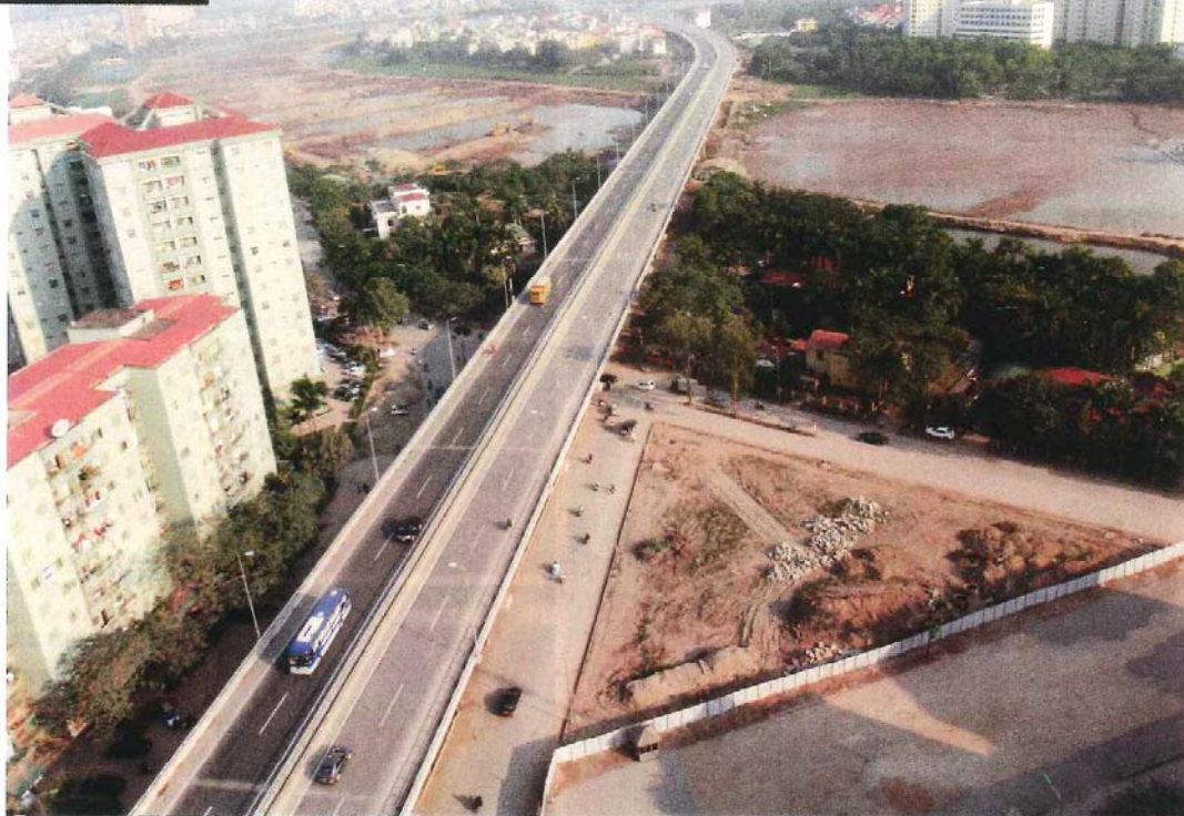
完成した工区全景
