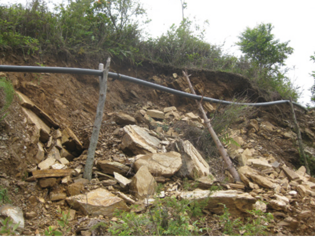
写真-3 導水管応急復旧状況
