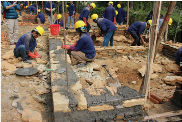
写真-7 石工に対する住宅再建トレーニングの様子
