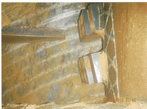
写真-4 カッターヘッド岩切削状況
