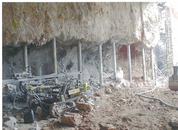
写真-5 デリーゲート駅岩掘削状況
