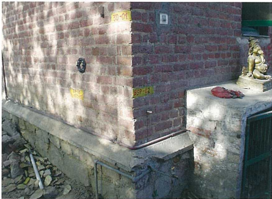
写真-7 傾斜および沈下計測ポイント設置状況
