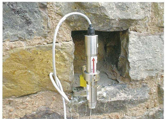
写真-9 自動傾斜計設置状況
