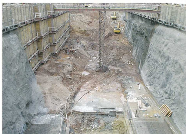
写真-2 ジャママスジッド駅土留め状況
