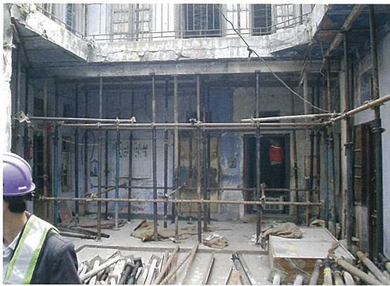
写真-6 建物補強状況（屋外）
