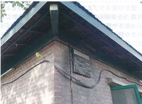
写真-8 三次元ターゲット設置状況
