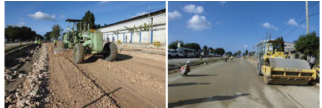
写真-5 下層路盤の工事状況
