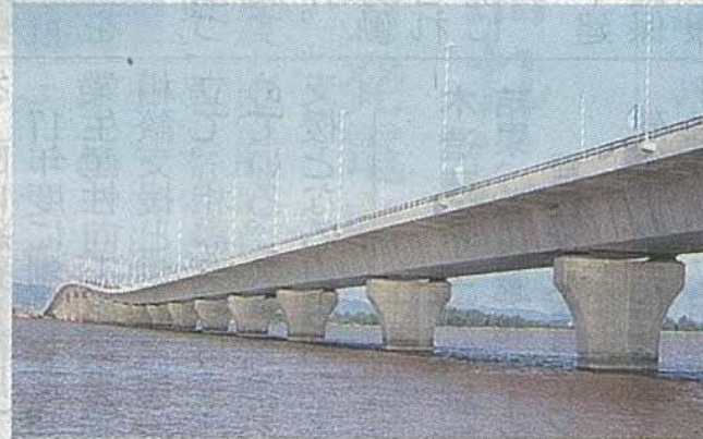
橋梁区間の延長は5・4kmに達する
