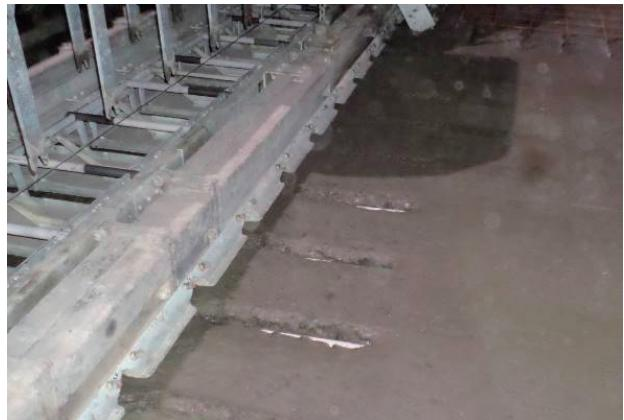
写真-5 スリップバーの施工状況
