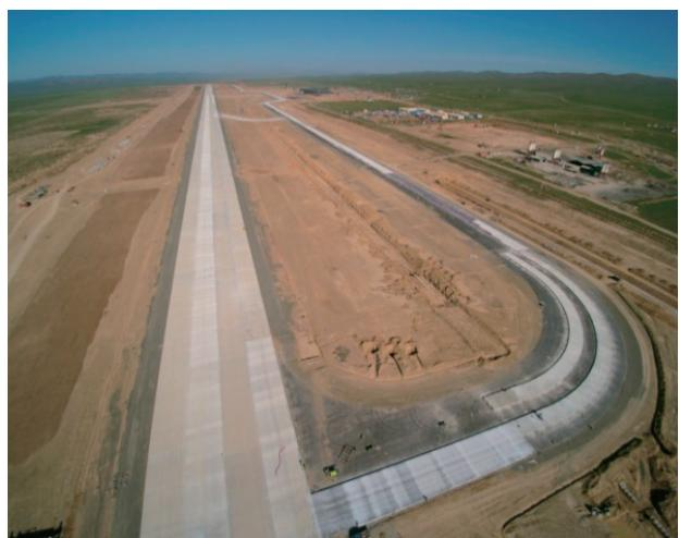
写真-2 滑走路のコンクリート舗装
