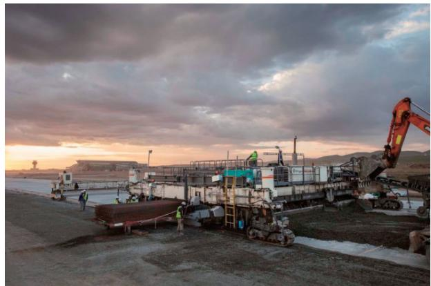
写真-4 滑走路コンクリート舗装施工状況
