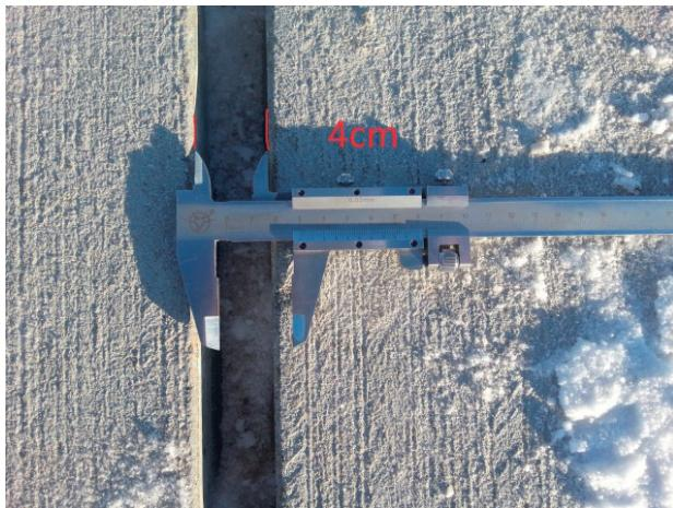
写真-3 冬季のコンクリート舗装の膨張目地の状況
