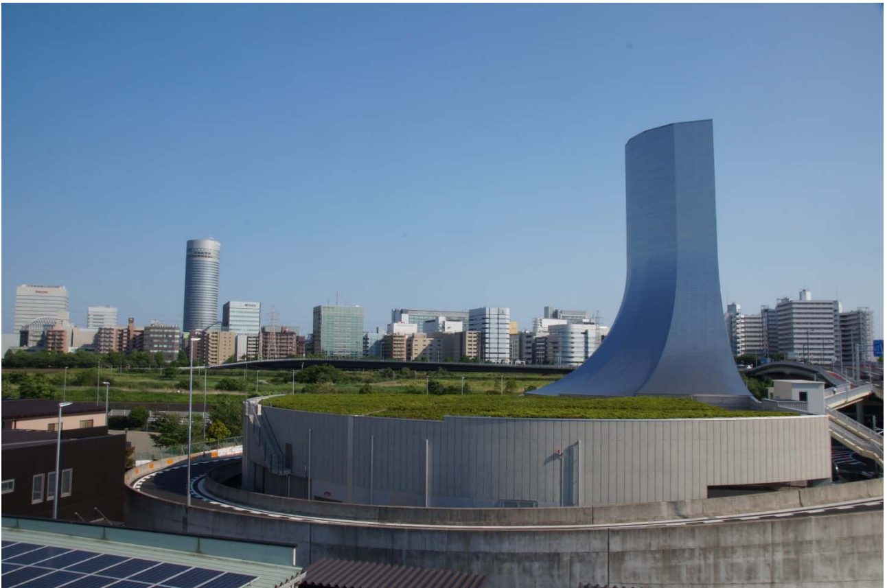
新横浜換気所
