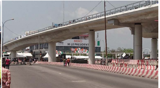
開通した跨道橋
