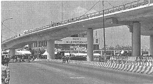
開通した跨道橋
