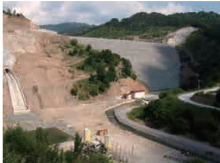
クネゼヴォダム(多目的ロックフィルダム)。このダムから6自治体に対し、1日に約72,000m<sup>3</sup>の水道原水を供給する能力を持つ。
