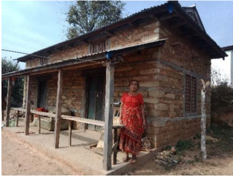
再建された住宅
