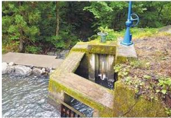
ゲート交換など既存取水口の機能を向上させた
