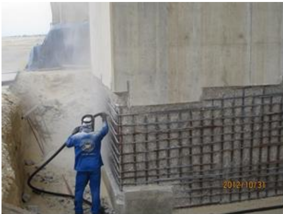
橋脚の鉄筋さび除去状況
