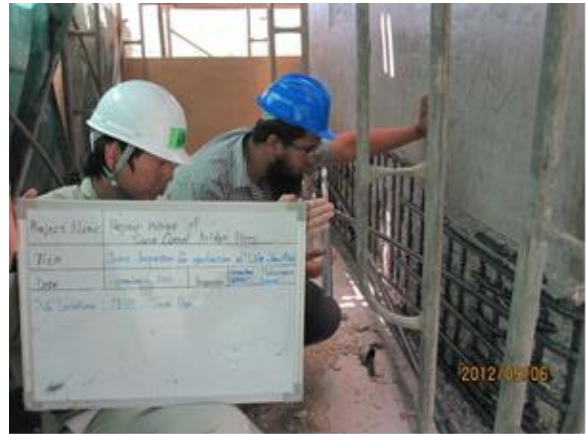
日本企業が実施した工事の検査をする エジプト人技師
