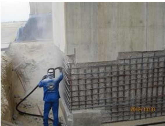
橋脚の鉄筋さび除去状況
