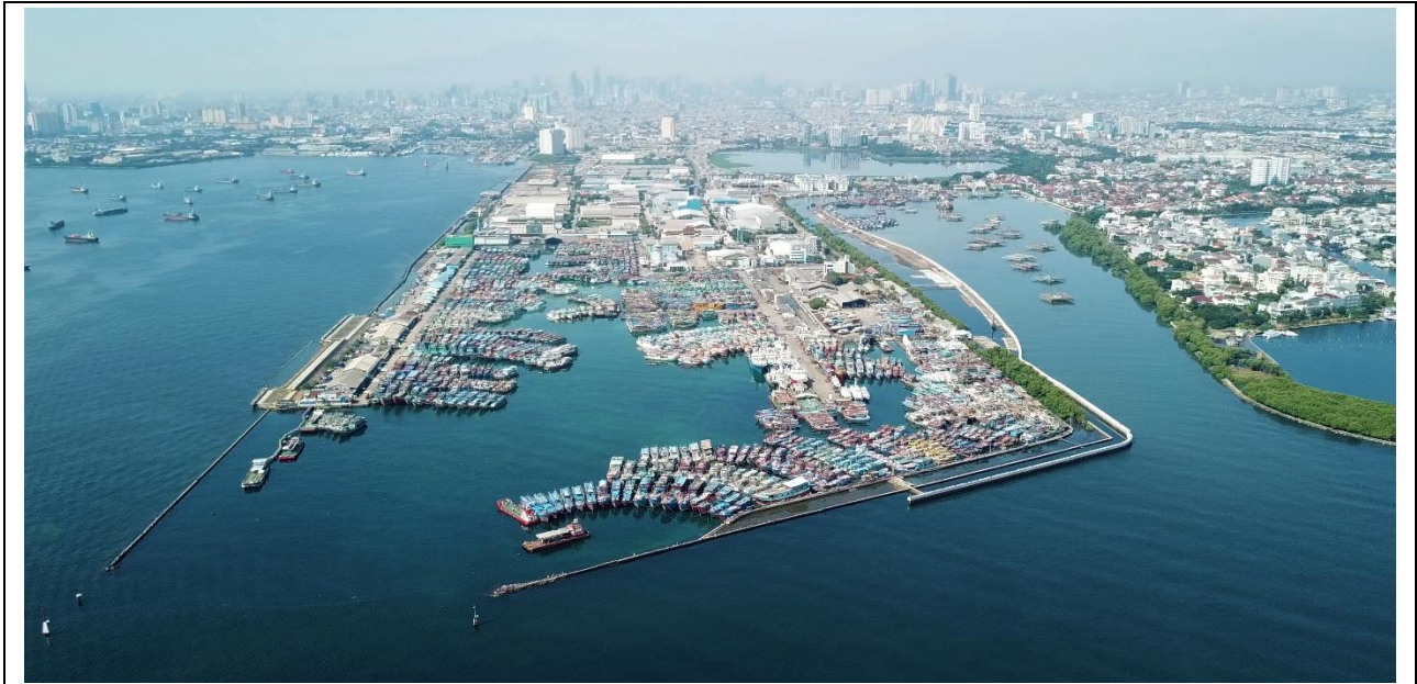
ジャカルタ漁港 沿岸の樹林はマングローブ防波堤・護岸（2022年撮影）
