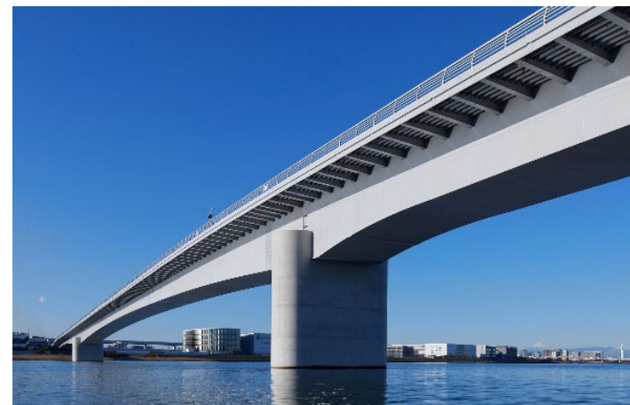
多摩川スカイブリッジ
