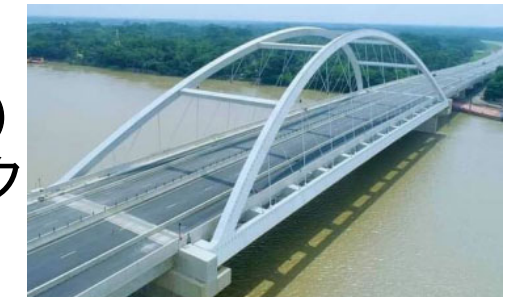
カルナ橋全景
