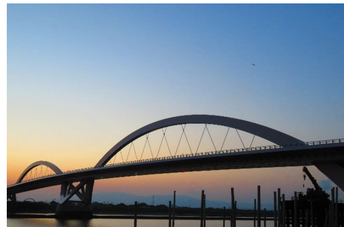
有明筑後川大橋
