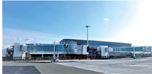
新設された旅客ターミナル （報道発表資料から）
