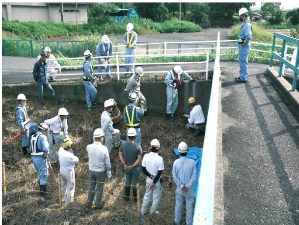
ひびわれ補修の実演（桁下）
