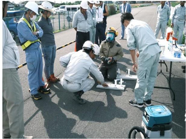
ひびわれ補修の実演
