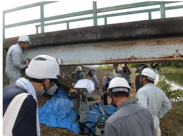
断面修復工の実演（桁下）
