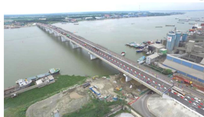
完成したメグナ第2橋梁と既設橋
