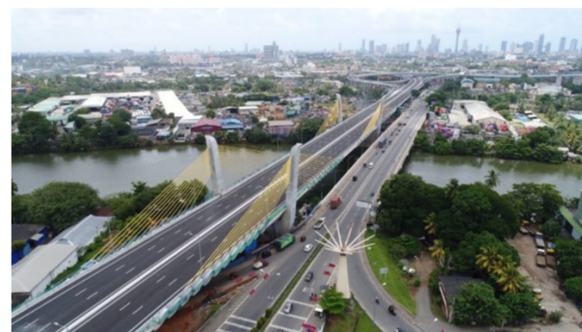
ケラニ河新橋の全景
