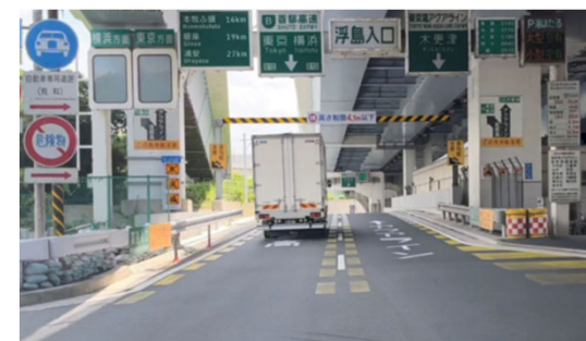
浮島入口の追加安全対策
