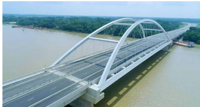
モドゥモティ橋（カルナ橋）全景
