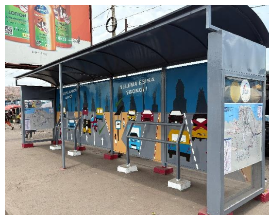
完成したバスシェルター
