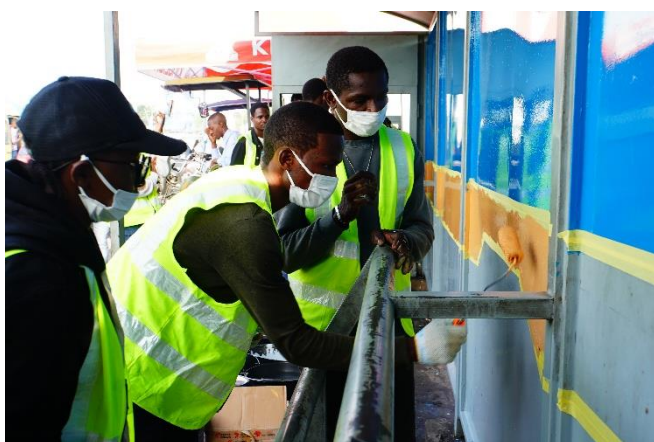
大学生によるバスシェルターの壁面塗装作業
