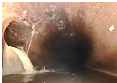
《下水道管路内撮影状況》
