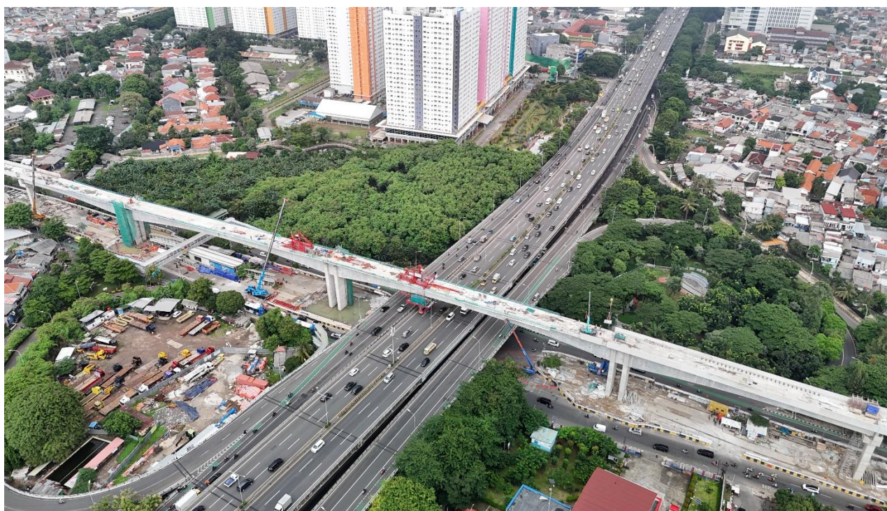
4 径間連続 PC 箱桁橋(張り出し架設工法)
