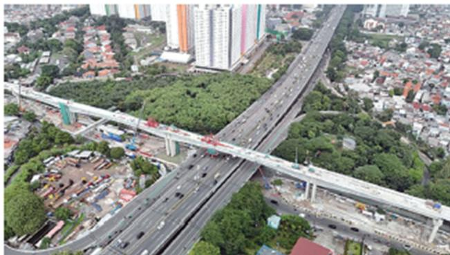
張り出し架設工法で施工される4径間連続PC箱桁橋
