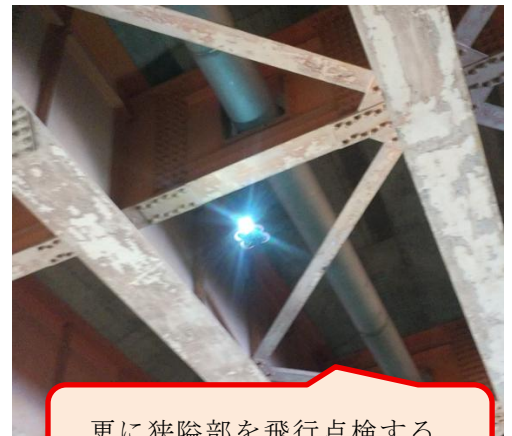
更に狭隘部を飛行点検する ことが可能となりました。
