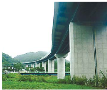
三陸沿岸道路「普代道路」にある普代大橋（10径間連続コンクリート複合ラーメン橋、橋長例、東北地方整備局・建設技術提案（3D寫）を基に、脆弱地盤上の耐震性と維持管理性に優れた支承レスの鋼鉄桁とRC橋脚の複合ラーメン構造）
