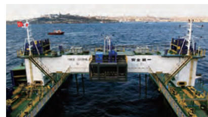
ボスボラス海峡横断鉄道のトンネル沈設状況。
