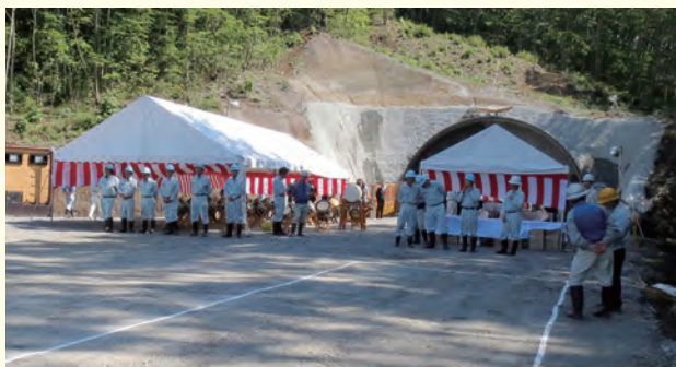
宇部トンネルの工事進捗状況を視察。
