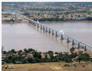
ラオス・タイ 第2メコン国際橋建設事業
