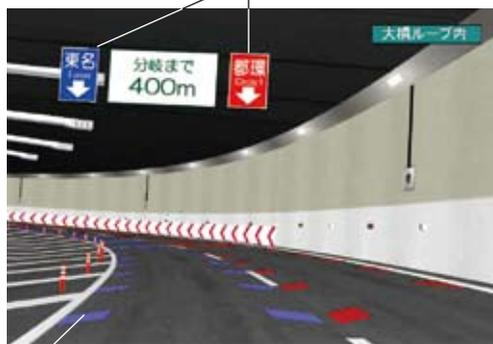
進行方向別に色分けされ、滑り止め舗装された路面
