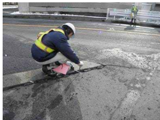
▲橋梁点検調査風景
