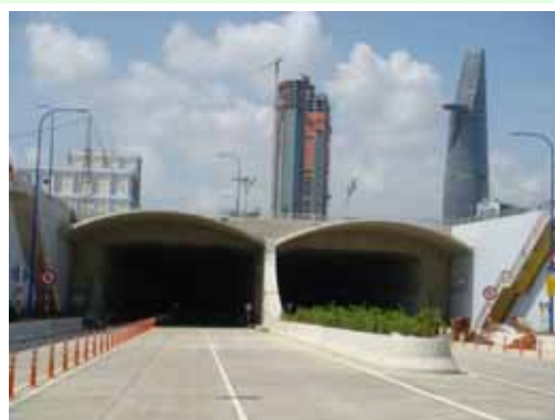
▲沈埋トンネル坑口写真
