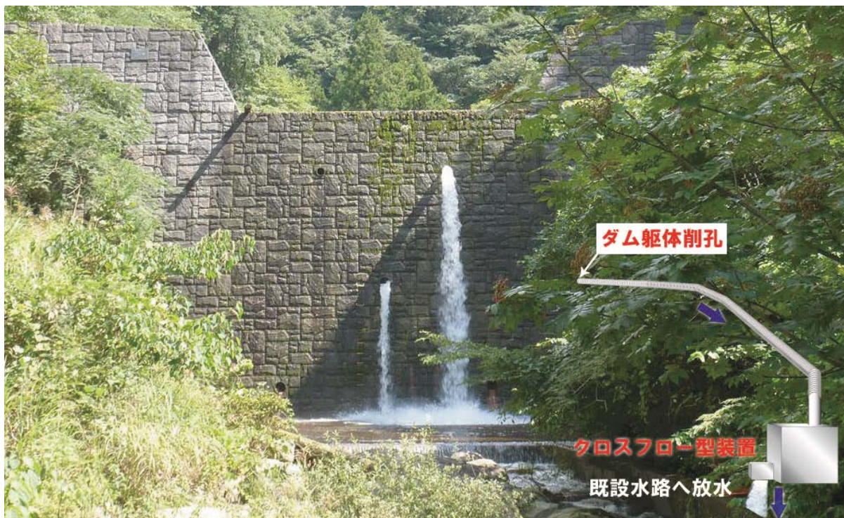
▲実証実験箇所(弓谷第2ダム えん堤)
