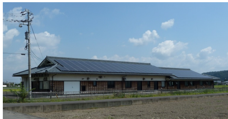
太陽光発電施設 (白崎地区農業集落排水処理施設)
