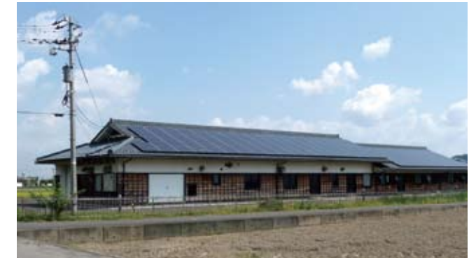
施設の外観。230Wのモジュールが172枚使用されている。
