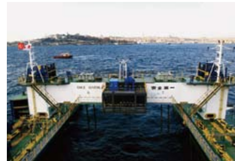
ボスポラス海峡横断鉄道のトンネル沈設状況。
