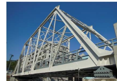
霞橋(旧江ヶ崎跨線橋を再利用)
