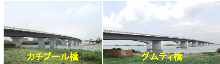
国道1号線に架橋されている橋梁保全事業
