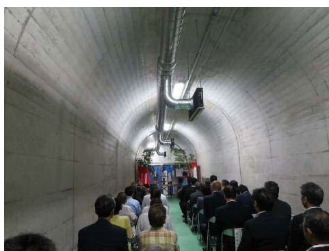
シェルター内部(横坑)
