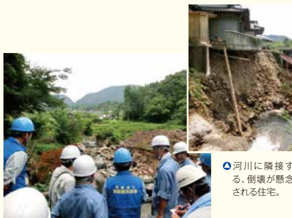
被災直後、災害エキスパートが視察し、現地の状況を調査。
